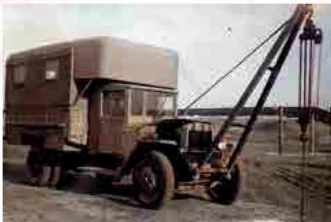
Авторемонтная мастерская типа «Б» и ее оборудование на шасси ЗИС-5В ульяновского производства
